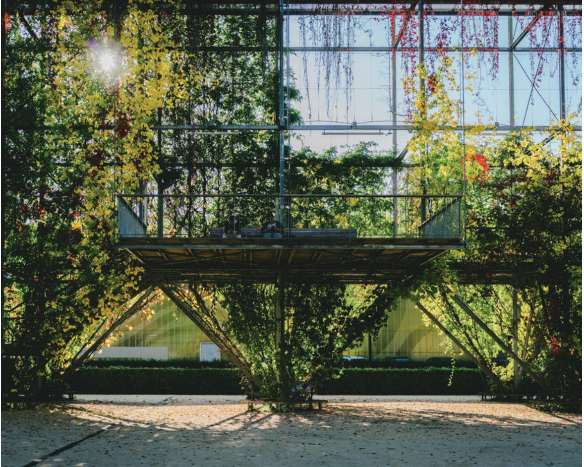
Der MFO-Park in Oerlikon entstand 2002 im Rahmen der Gebietsentwicklung «Zentrum Zürich-Nord». Die verzinkte Stahlkonstruktion mit Rankhilfen aus Stahlseilen wird von diversen Kletterpflanzen begrünt. Im Herbst sorgt ein wilder Wein für ein grossartiges Farbenspiel, während die Besucherinnen und Besucher des Parks im Sommer von einem üppigen Grün begrüsst werden. (Bild: Claudio Schwarz / Usplash)
