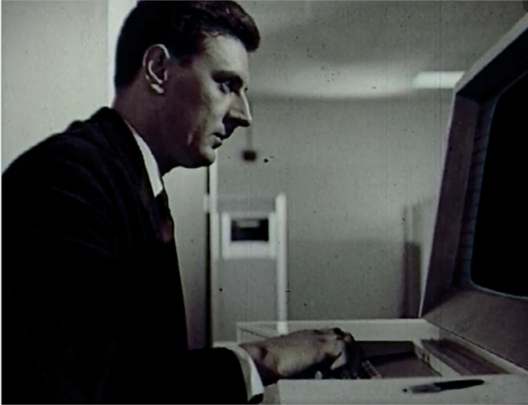
Hans Bodmer am CERN 1965 an der damals revolutionären Systemkonsole der CDC 6600 mit zwei Bildschirmen und einer Tastatur. Übliche Konsolen bestanden zu dieser Zeit aus Hunderten von Schaltern und Lämpchen. (Bild CERN 1965)
