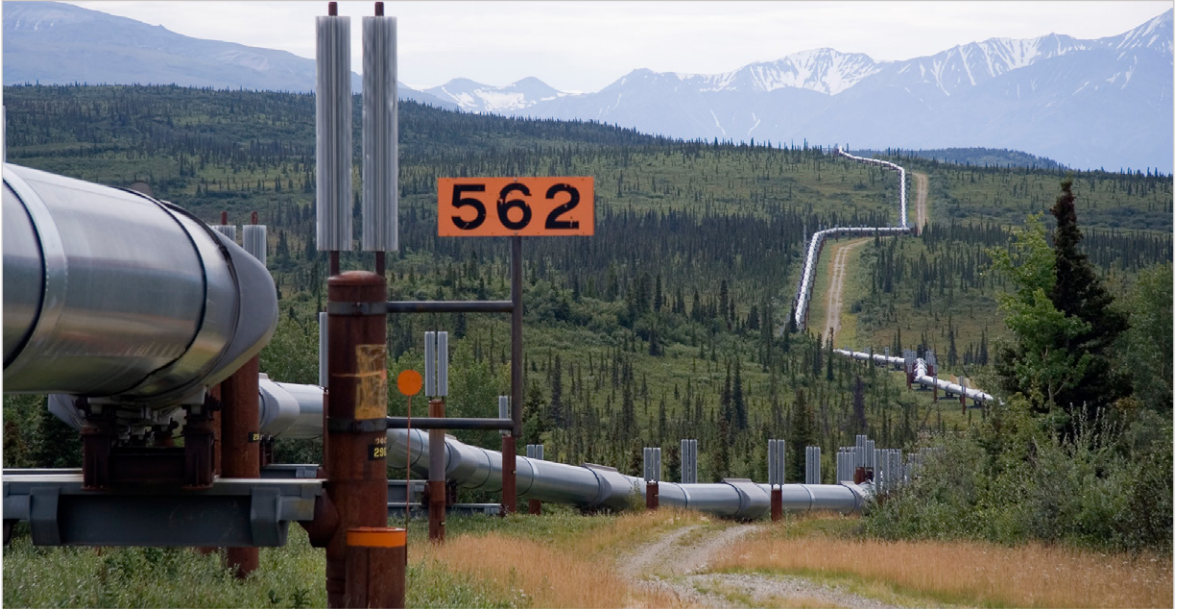
Trans-Alaska Pipeline. Die grauen Kühlfinger-Paare kühlen das obere Ende der Wärmerohre mit Hilfe der kalten Luft. Das untere warme Ende ist verbunden mit den Pfählen, die im Permafrost stecken. Diese werden dadurch gekühlt und so wird verhindert, dass der Boden auftaut.
